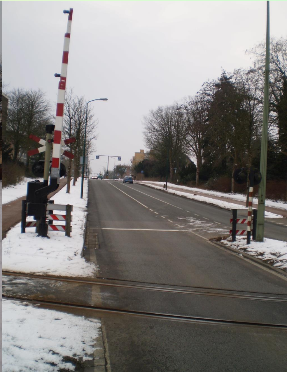
Dalweg richting Overhees
